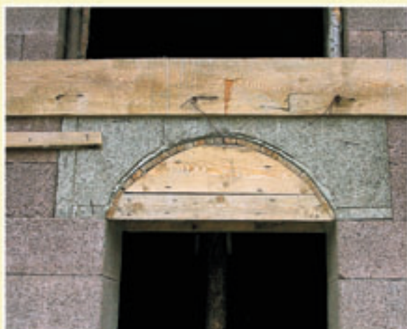
↑ Монтаж арочных проемов ↓
