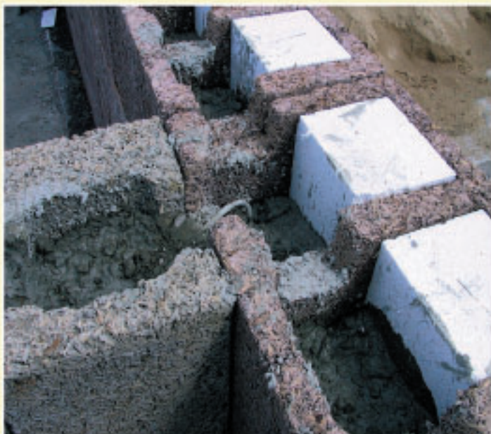
Стыковка стен ↓
