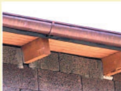
Установка балок перекрытия ↑
