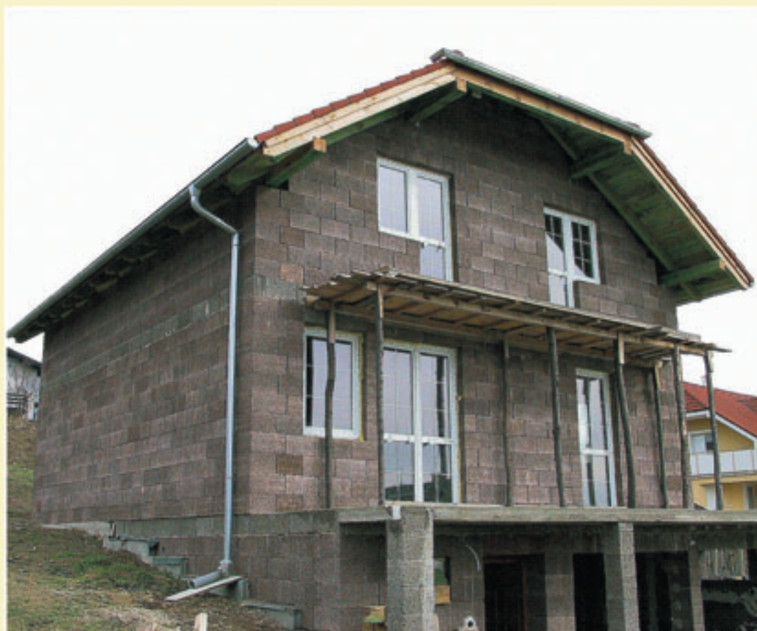
↑ Дом по технологии DURISOL на стадии строительства
