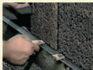
↑ Выравнивание блоков
