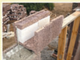
↑ Монтаж перемычки
