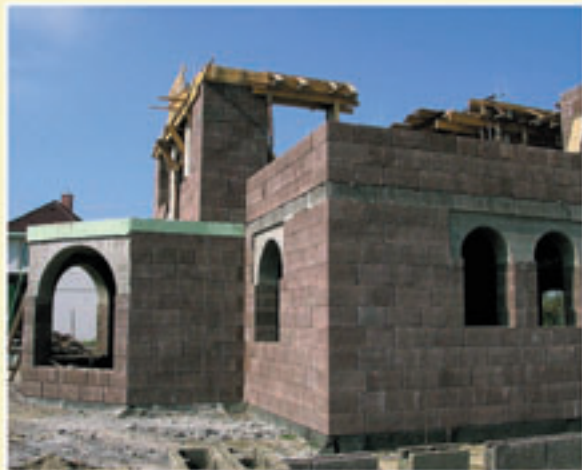
↑ Монтаж арочных проемов ↓
